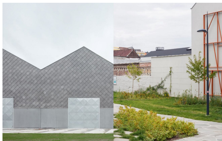
Links: Basisschool De Linde in Zarren van FELT architecture & design / Rechts: Standaertsite Gent van ea/Carton123 en murmuur architecten
